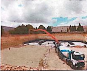
Çorobeton dökülmesi
