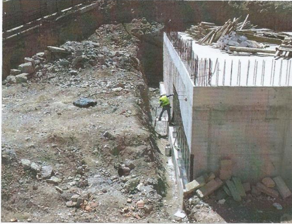
Otopark binasının dış cephesinin yalıtılması
